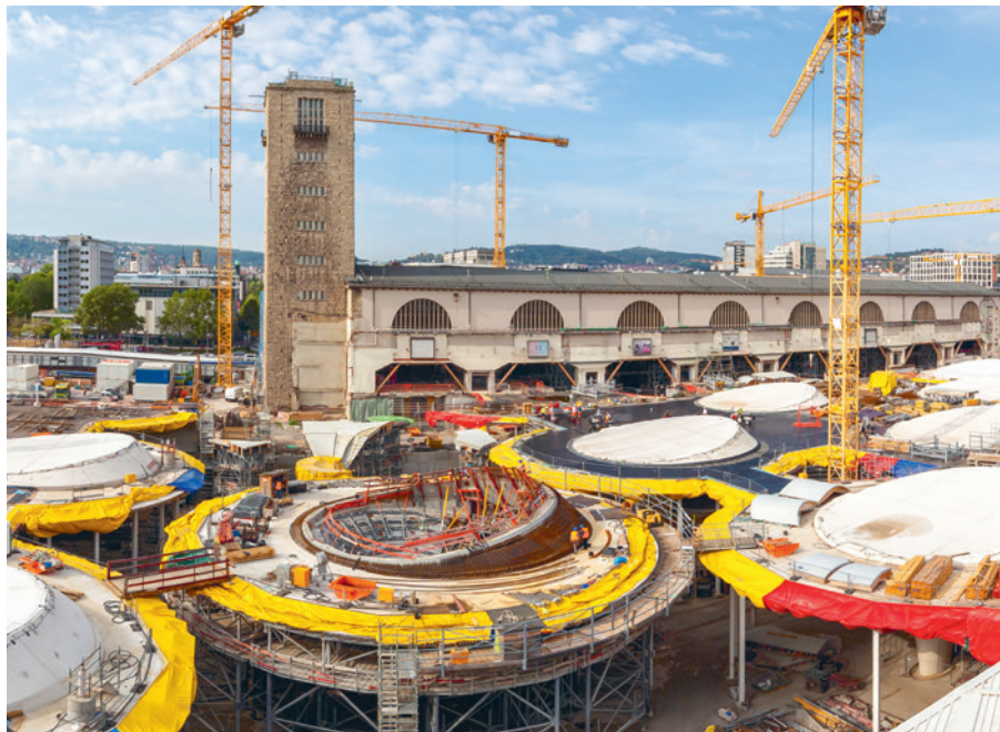
Die Großbaustelle von Stuttgarts neuem Hauptbahnhof: Allein bei der Bahn gibt es bis 2027 einen Investitionsbedarf von 45 Milliarden Euro
